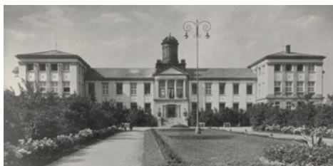
Severní průčelí původní Správní budovy velkostatku Poděbrady. Reprodukce z: Zlatý pruh Polabí, o.p.s.
