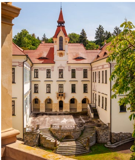
nádvoří s kamenným schodištěm
